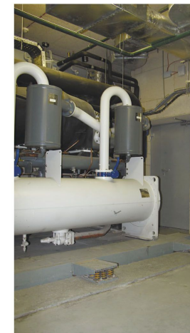
Виброизоляция чиллера Виброизоляторы: Vibrofix Spring DSD Объект: отель Hilton, Киев
