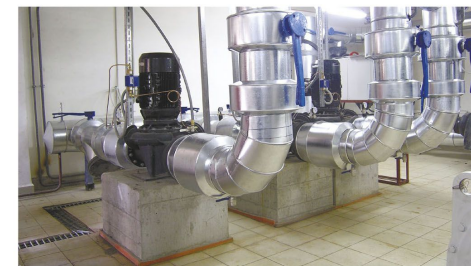
Виброизоляция магистральных насосов Виброизоляторы: Vibrofix Block Объект: отель Fairmont, Киев
