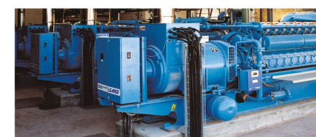
Виброизоляция генератора с помощью Vibrofix Block
